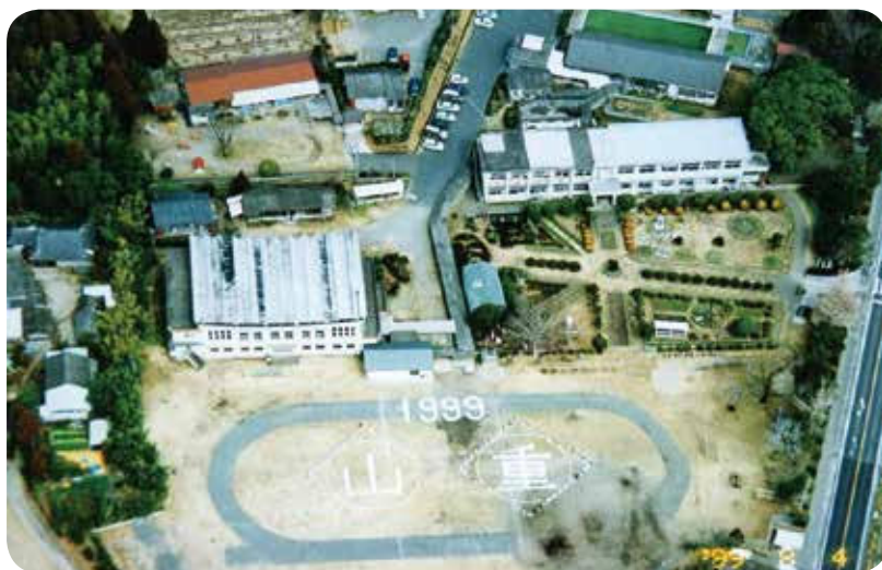
写真は、平成11年（1999）の山重小学校の空撮
